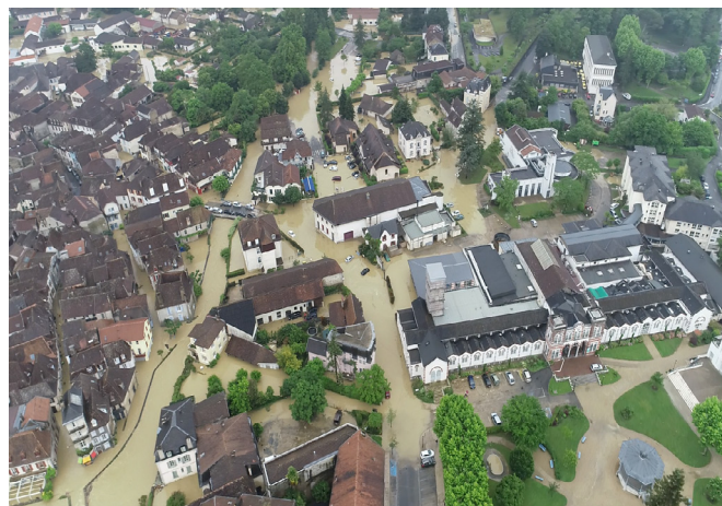
Salies de Béarn inondée en juin 2018 (source : SDIS64)
